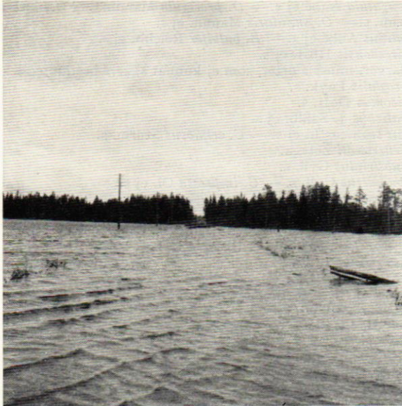
Fig. 4. Lägre liggande delar av vägen hade helt översvämmats. 7/6 1955. — Foto: förf.
